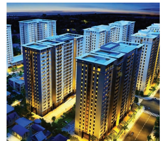
Ha Dong The Vesta Project
